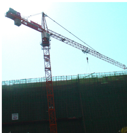
圖 1.40 塔式起重機是非對稱平衡設計的另一個例子
