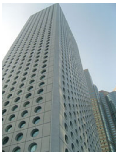
圖 1.31 中區怡和大廈整齊排列的窗戶，形成均衡重複的效果。
